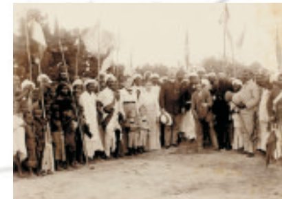
Oben: Erster Spatenstich zur Kirche in Pandur (1906), Rechts: Die fertiggestellte Kirche
