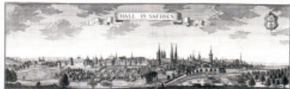
Gesamtansicht von Halle Kupferstich von J. Wolff, um 1730
